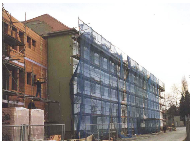
Bauarbeiten Gebäude Macherstraße 63 (Zwischenbau und Südflügel), 1995
