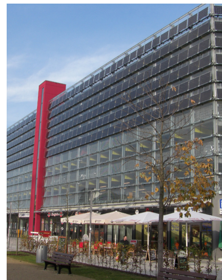
Bild 4 Sonnenschutz-Fassadengestaltung mit Photovoltaikanlagen Parkhaus Roter Turm Chemnitz
