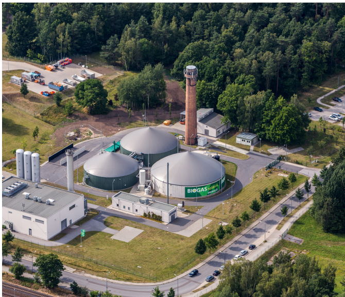
Bild 7 Biogasanlage und Heizkraftwerk (links) Dresden-Klotzsche, DREWAG
