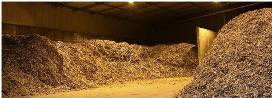
Bild 1 Altholzspänelager des Biomasse-Heizkraftwerkes Dresden, STEAG GmbH
