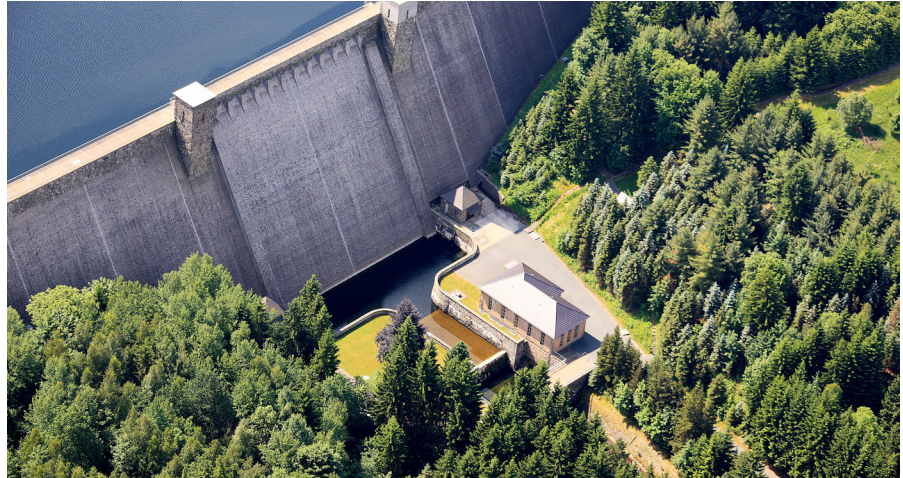
Bild 2 Wasserkraftwerk Lehmühle mit Talsperre
