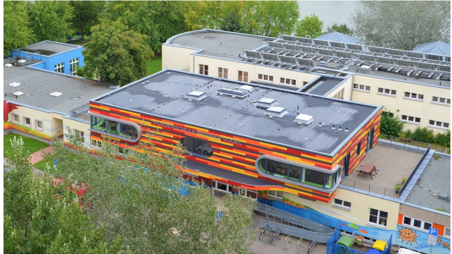
Bild 5 Solarthermieanlage auf einer Schule in Leipzig zur Beheizung der Schule und des Schwimmbades
